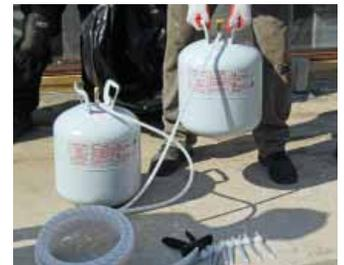
Agite los tanques de lado A y lado B
